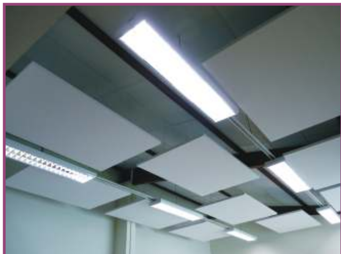
Travaux d'insonorisation de la cantine
